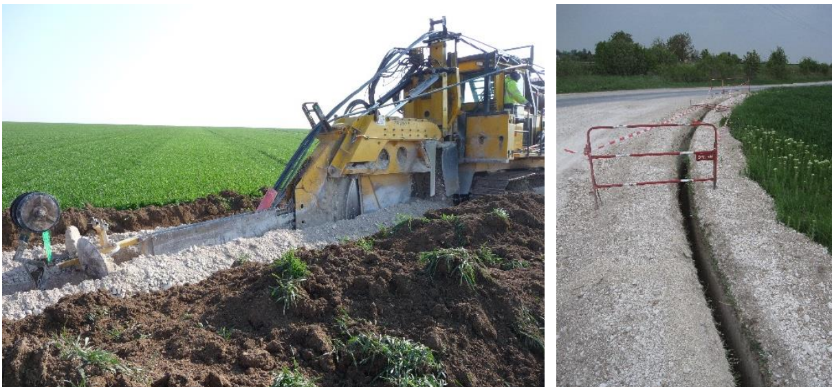
Figure 2. Exemple de tranchée réalisée (Source : TotalEnergies Renouvelables France)
